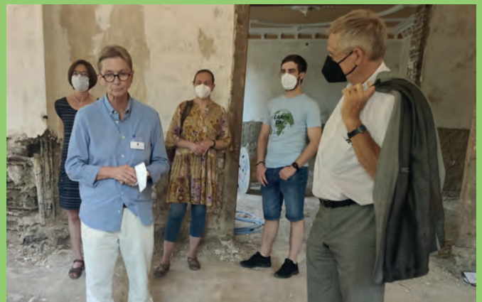
Besuch in der durch die Flut zerstörten Ehrenwall'schen Klinik
